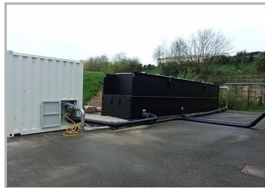
Unité de Traitement Mobile (UMT) composée d'un décanteur lamellaire et d'un container technique
