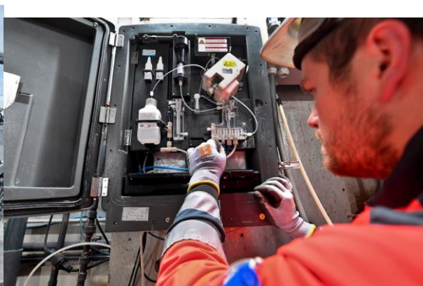
Interventions électro mécaniciens
